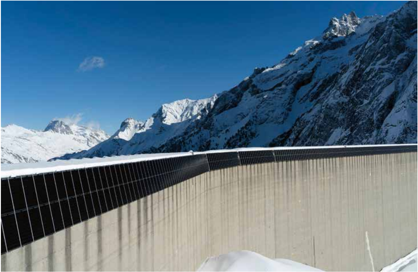
Ausschliesslich erneuerbare Energien: Albigna-Staumauer im Bergell.
